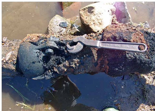
Fernkabel FK501, Kabelschutz wird gelöst
