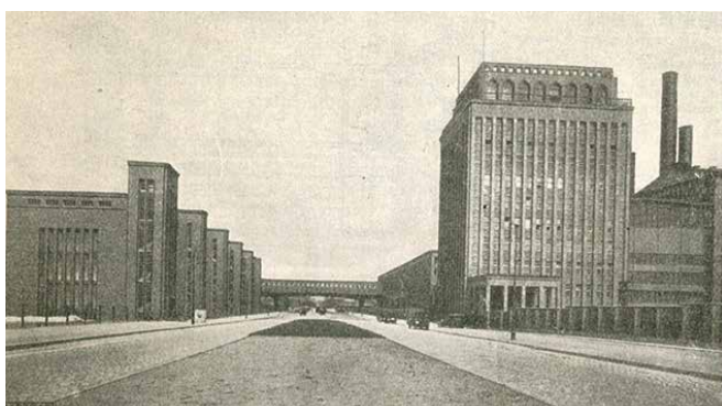
30-kV-Schalthaus, Verbindungsbrücke über die Köpenicker Chaussee und Hochhaus, GWK Klingenberg, 1927 [16]
