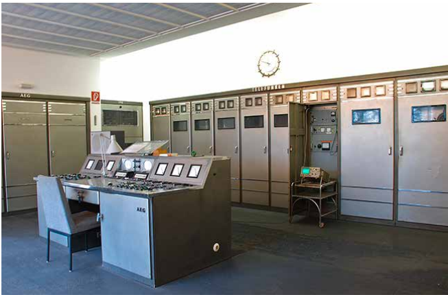
20-kW-Kurzwellensender von Telefunken in Berlin-Britz, Baujahr 1951, Foto aus dem Jahr 2008 Foto: G. Roleder
