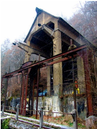
Einlaufbauwerk zum Druckstollen
