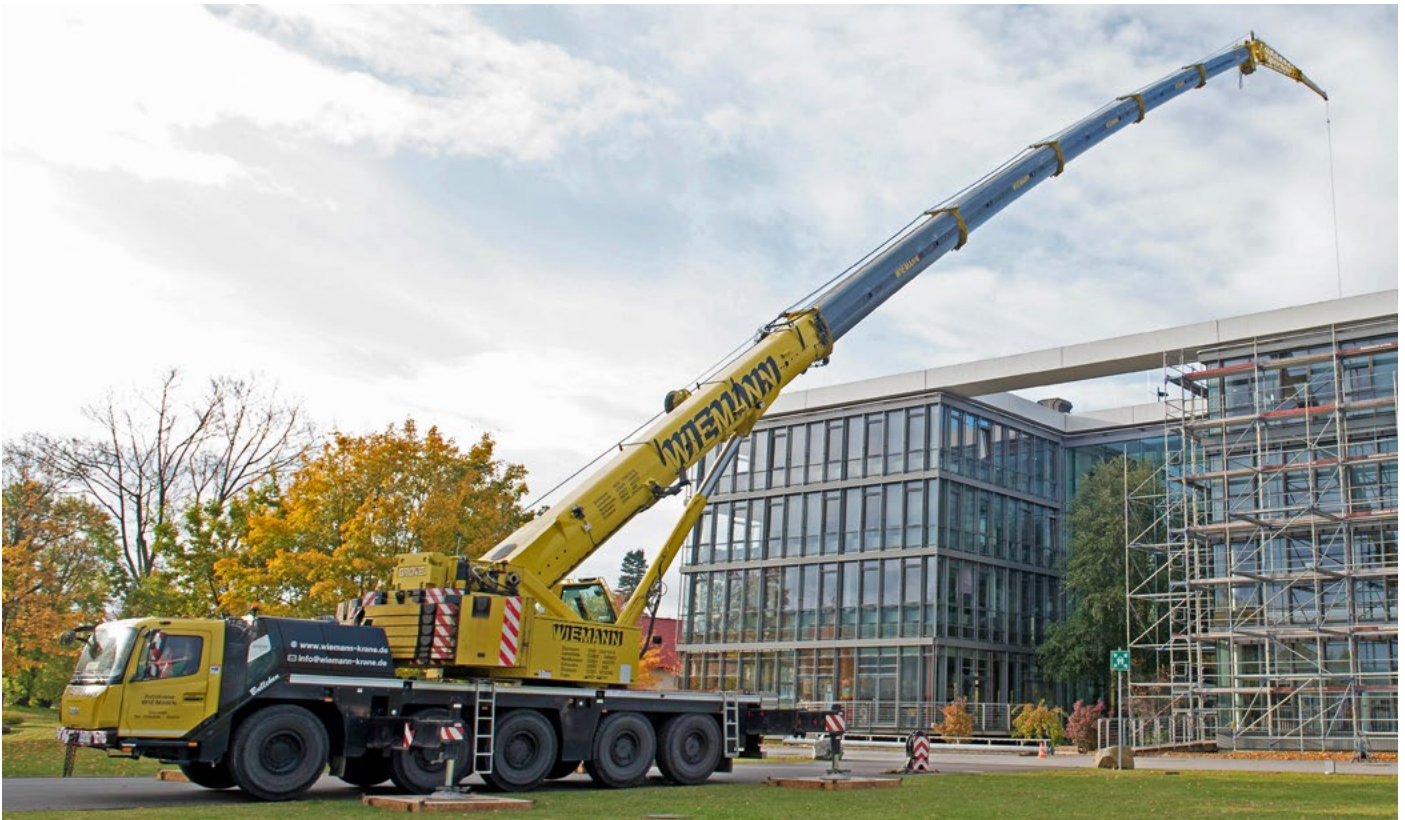
Antennenmontage auf dem Dach des MDR-Funkhauses in Erfurt, Oktober 2021
