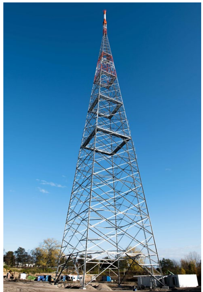
Funkturm der Sendestelle „Messegrund“ in Leipzig während der Bauphase, November 2015
