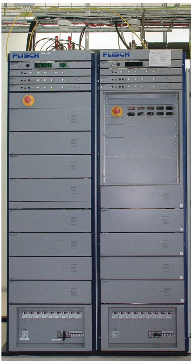
Zwei Sender für DAB+ in der Sendestelle Ettersberg bei Weimar, der ersten Sendestelle für DAB+ in Thüringen, November 2011
