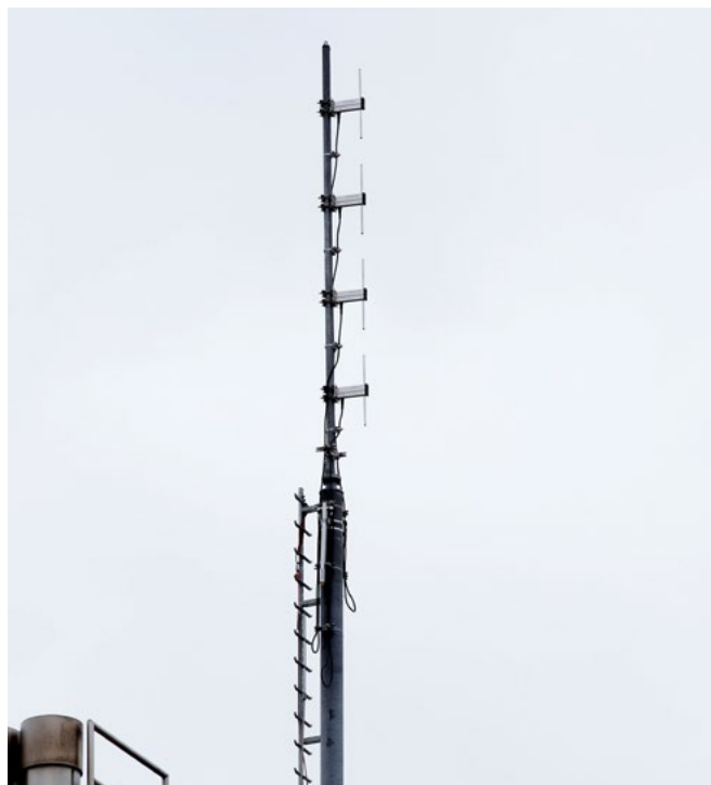
Vierfach gestockte Dipole für DAB+ auf dem MDR-Funkhaus in Erfurt, Inbetriebnahme im November 2021
