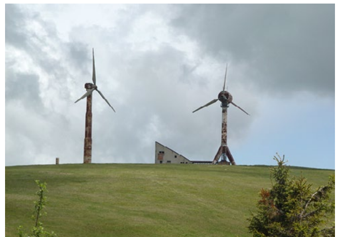
Südansicht der windelektrischen Aggregate
