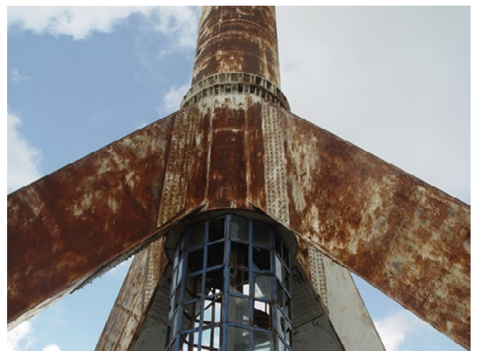
Pilotanlage mit Aufgang zur Gondel
