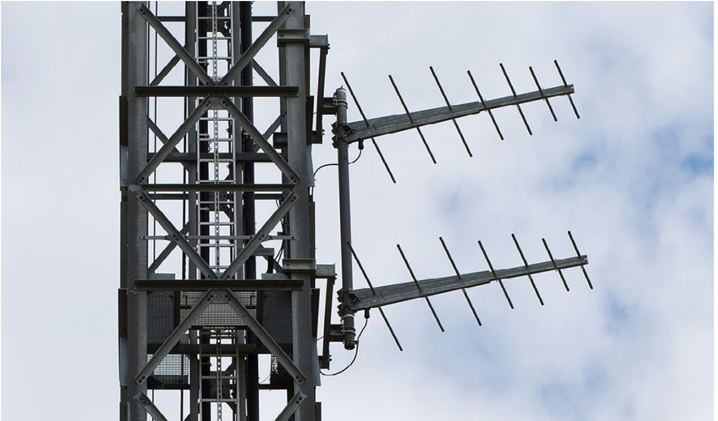
Logarithmisch periodische Dipolantennen für das UKW-Band II (87,5 MHz bis 108 MHz), hier als Antennen für Ballempfang am Antennenmast einer Rundfunk-Sendestelle; Antennen dieses Typs sind ebenfalls Thema des Antennenbuches (Foto: G. Roleder)
