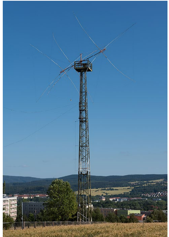
Diese drehbare Richtantenne des Typs „Cubical Quad“ für Kurzwelle basiert auf Vorgaben des Antennenbuches. Es handelt sich um einen Eigenbau von Mitgliedern der Klubstation DA0HQ in Ilmenau. Die Mannschaft von DA0HQ erreichte bei der Kurzwellen-Weltmeisterschaft der International Amateur Radio Union im Jahr 2019 den zweiten Platz. (Foto: G. Roleder)
